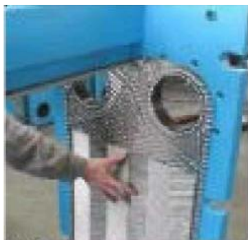
Рис. 15. Монтаж первой пластины
